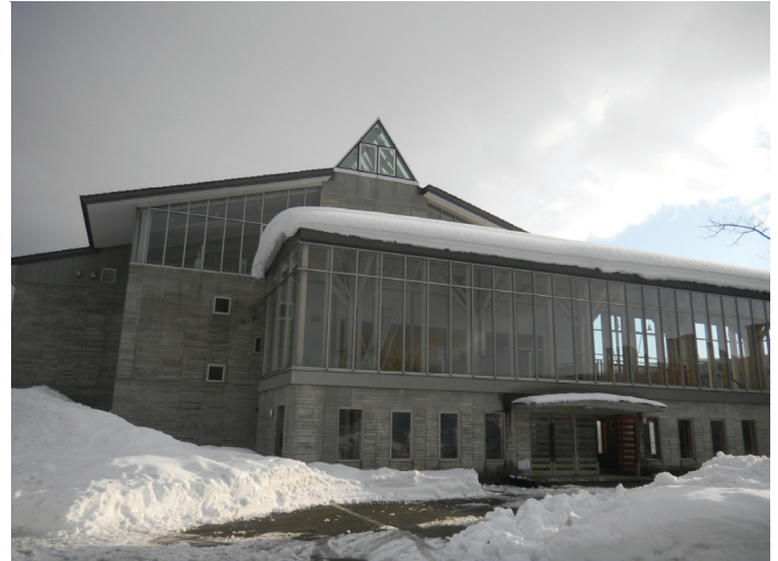
《外観写真》 外壁の表面には杉板の型枠の木目が現れている
