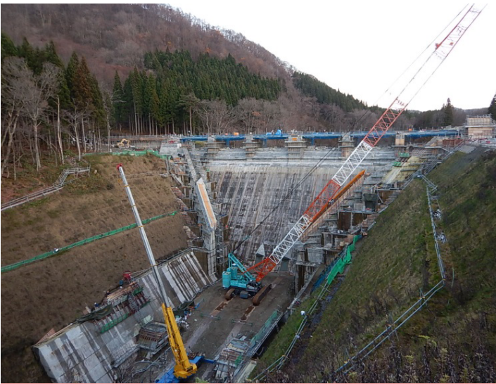
天端橋梁架設完了(12月)
