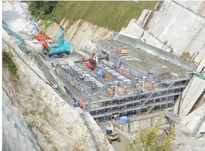
ダム堤体打設状況 (H29. 10)
