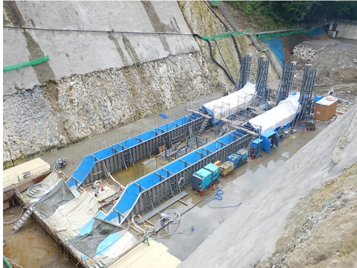
放流設備据付(2門) (H29. 7)
