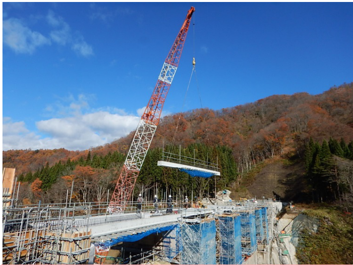
ダム天端橋梁架設(11月)
