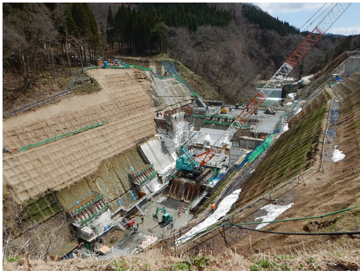
ダム堤体工事状況(4月)
