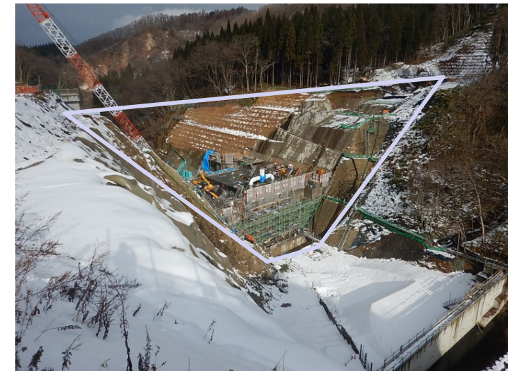
工事進捗状況 (H29. 12)
