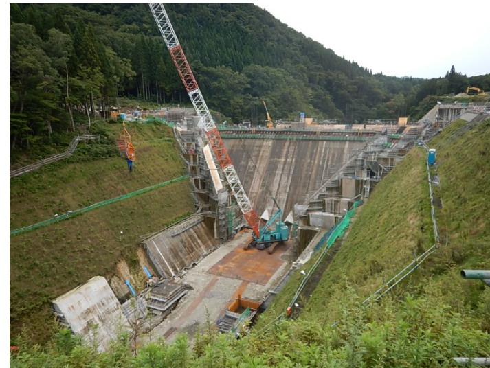
ダム堤体工事状況(9月)
