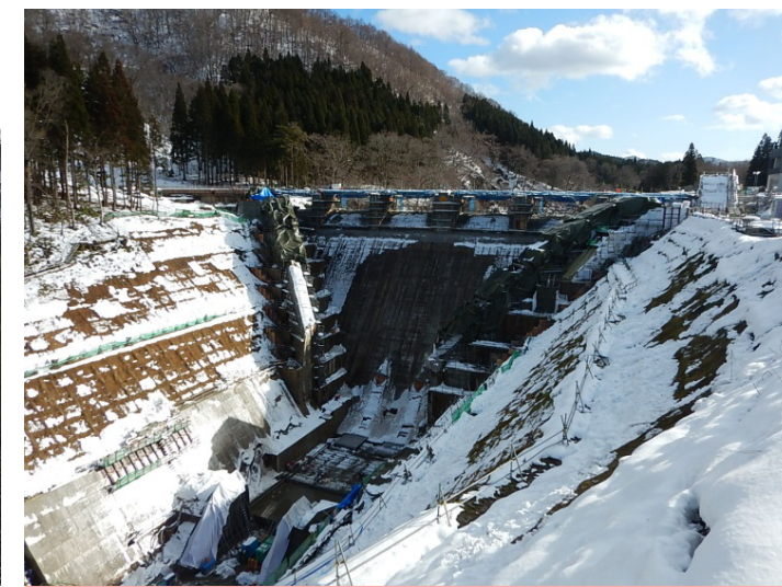
工事状況(H30. 12月)降雪時
