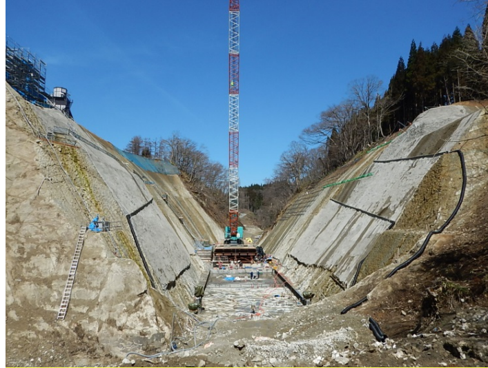
基礎掘削完了、堤体打設開始 (H29. 4)
