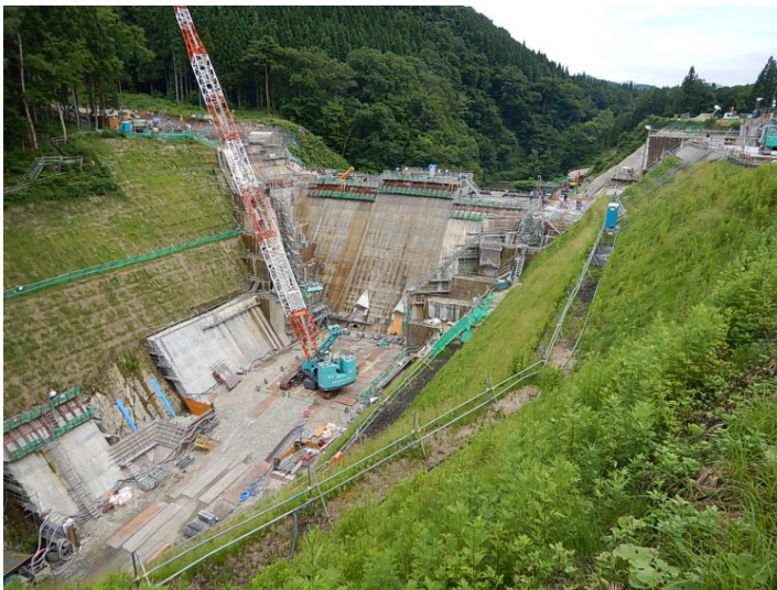
ダム堤体工事状況(7月)
