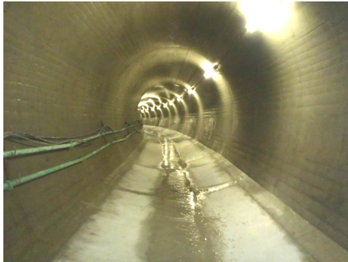
仮排水路(トンネル) H28転流開始
