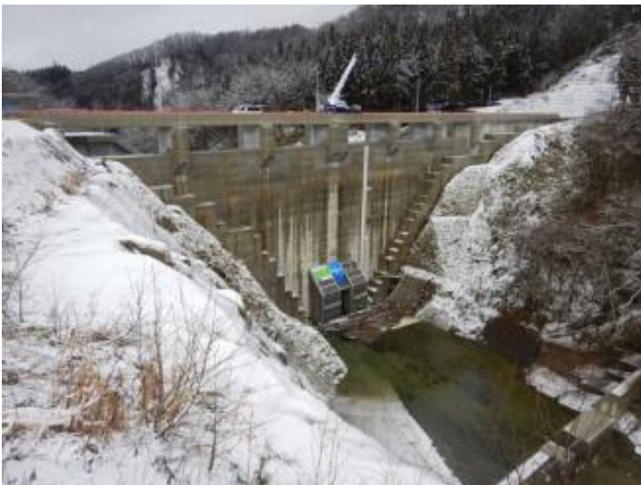
試験湛水状況 貯水前 (R1. 12. 27)
