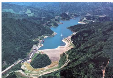
水源（寒河江ダム）
