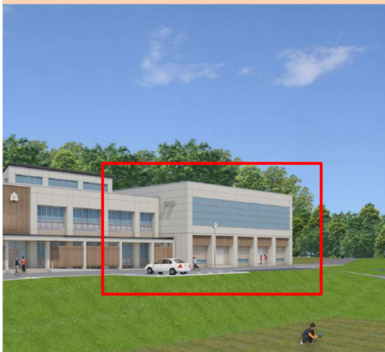
外 観（体育館：赤囲み部分）
