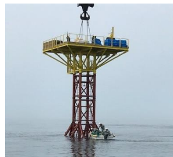
<ボーリング調査>
