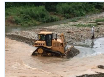
ブルドーザによる河床整正作業（川底を均し、流下能力の維持を図る）
