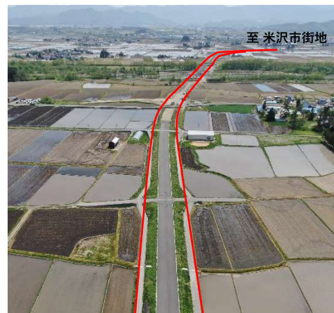
国道287号 (米沢長井道路)
