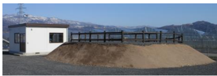
見学台と管理棟
