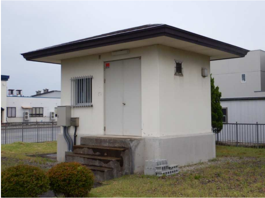
福田工業用水道取水場
