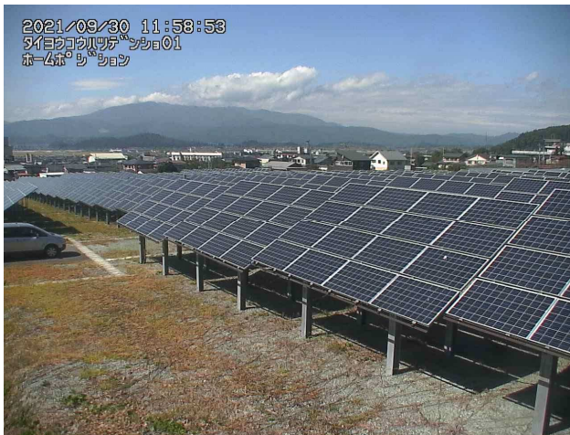
令和3年9月30日 12:00 太陽光発電所の状況
