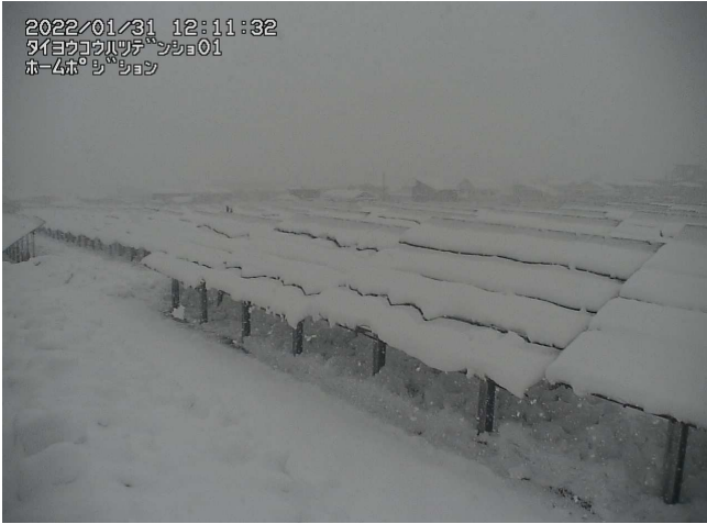
令和4年1月31日 12:11 太陽光発電所の状況
