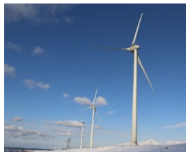
県営風力発電所
