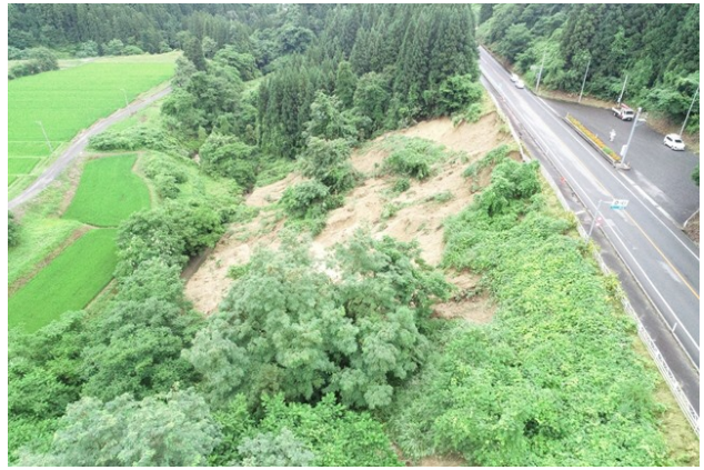
▲国道 348 号の法面崩壊 (白鷹町 R2.7)
