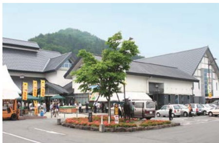
耐震基準に基づく建物・設備
