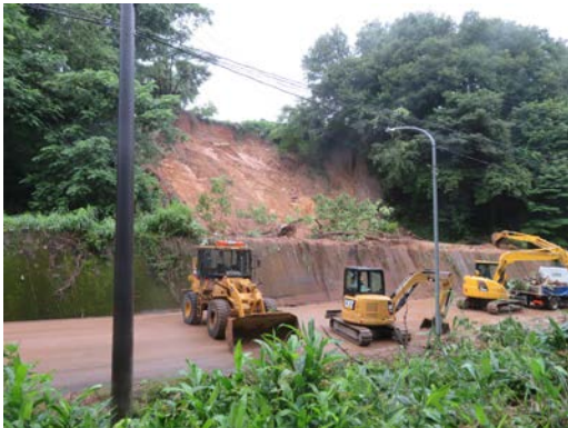
▲国道 287 号の法面崩壊 (朝日町 R2.7)
