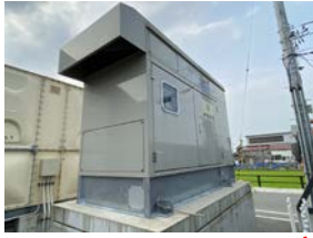
自家発電装置
