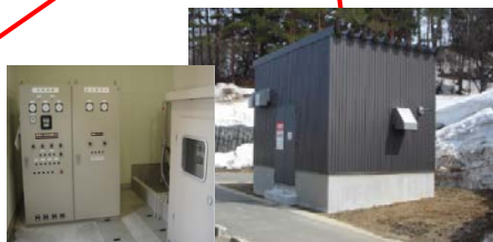
無停電化 (非常用発電装置) ・概ね3日間連続運転可能 ・情報提供施設、トイレへ電気を供給
