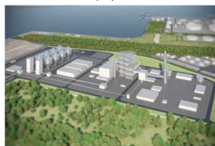
大型バイオマス発電所(計画) (新潟県聖籠町) イーレックス(株)報道資料より
