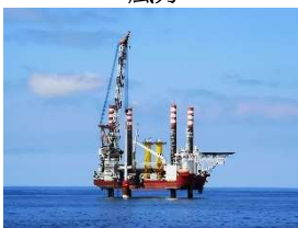
洋上風力発電(風車基礎工事) (秋田県能代港港湾区域内) 提供：秋田洋上風力発電株式会社
