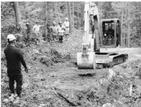
図3 作設実習状況 (転圧)
