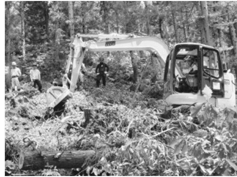
図2 作設実習状況 (除根)
