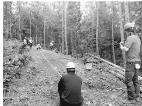
図4 出来形計測状況
