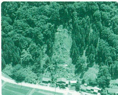
▼民家に直撃する土砂崩れ
