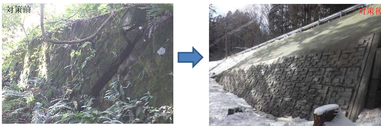
擁壁補修+上法面の植生を実施
