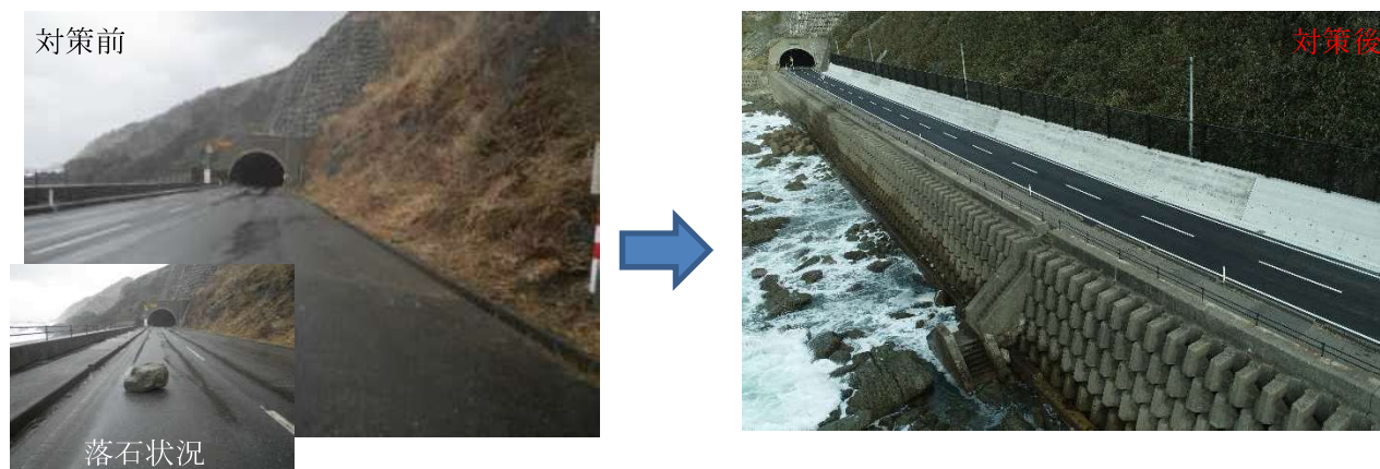
擁壁工+落石防護柵工を実施
