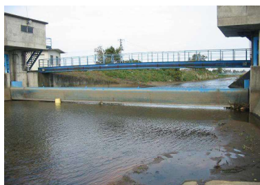
防錆対策の実施
