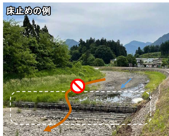
▲②流路保全対策（床止め）の対策後イメージ
