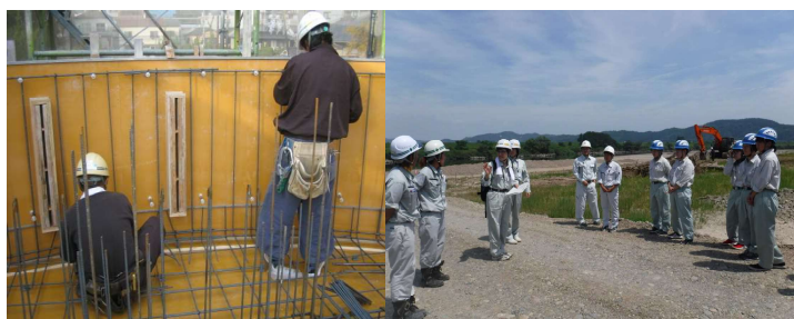
将来の建設業を担う、多様な人材の確保・育成が重要
