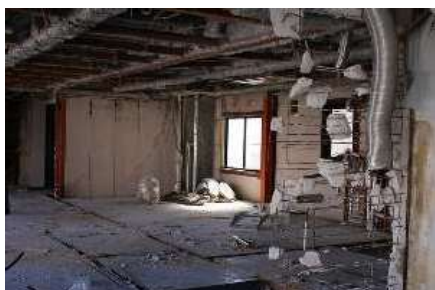
改修前（空きフロア）
