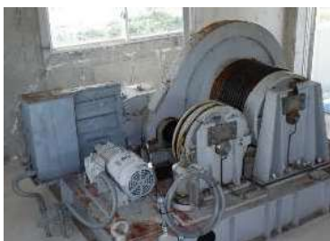
機械設備の補修の実施
