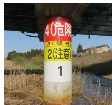
量水標設置状況 (拡大)
