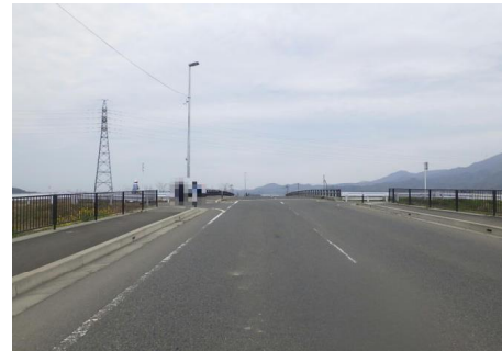
【Aから見た本件事故現場の状況】
