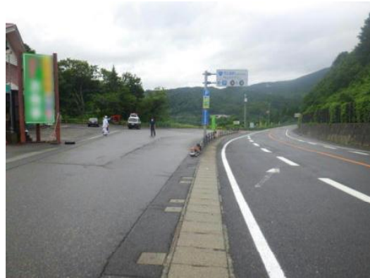
【Aから見た現場の状況】
