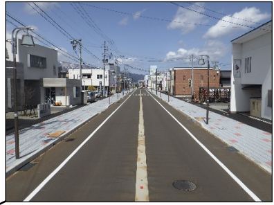
▲桐町成田線街路整備事業（県事業） L=390.2m W=16m [H22～R5]
