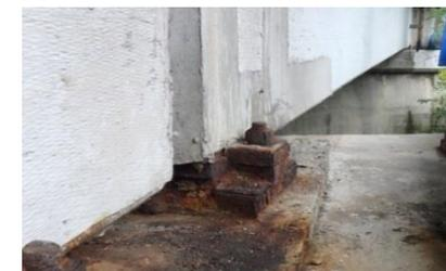
支承損傷状況(腐食)
