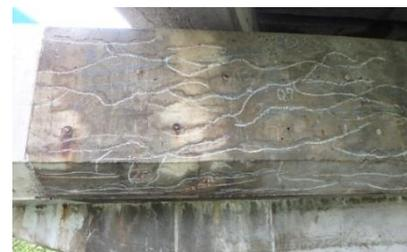
下部工損傷状況(ひび割れ)
