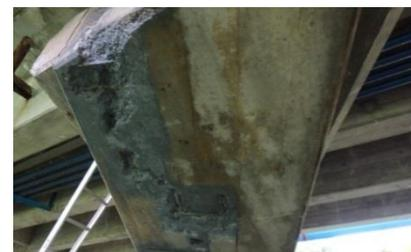
下部工損傷状況(鉄筋露出)
