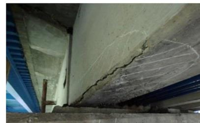
上部工損傷状況(ひび割れ)
