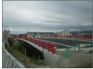
▲第2工区(花見橋)
