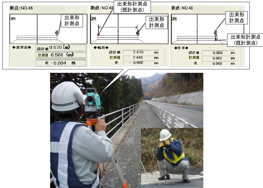
図－4 出来形計測状況
