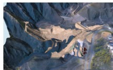
基礎掘削完了・仮設備配置
