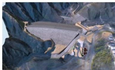
堤体盛立完了
