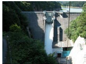
県営水力発電所(高坂ダム)
