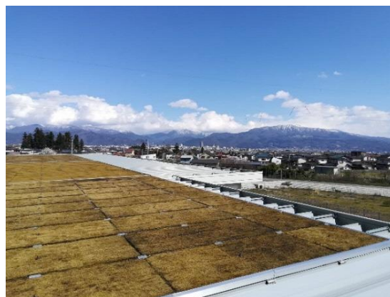
山形物流倉庫の屋根にコケボードを設置
