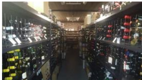
エアコンのいらない倉庫が実現しました
