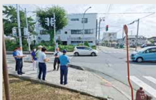
▲合同点検の状況
