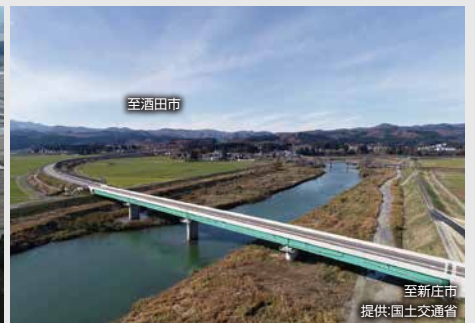
国道47号 新庄古口道路
