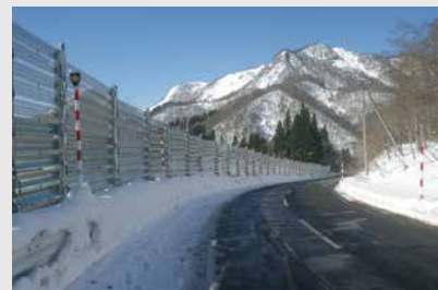
吹き溜り・視程障害対策（吹き止め柵）
