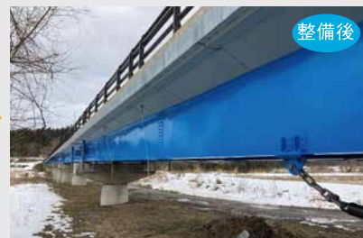
橋桁再塗装
