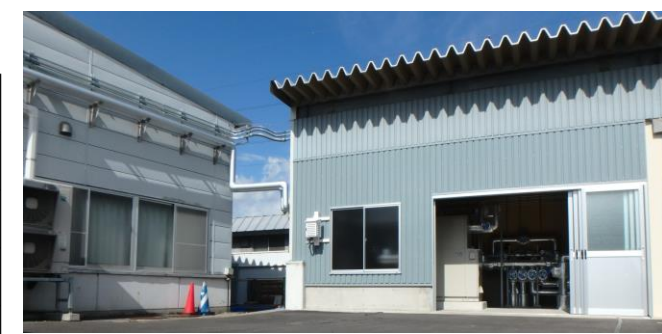
左: 冷暖房対象施設(180㎡)、右: 機器室 [施設外観]
