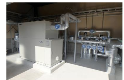
[機器室内の専用ヒートポンプと揚水注入ヘッダー配管]
