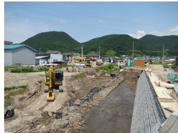
着工後 (施工中)
