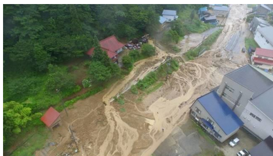
H30.8月の大雨による被災状況（戸沢村角川）
