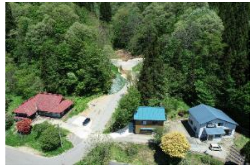
治山事業後の状況
