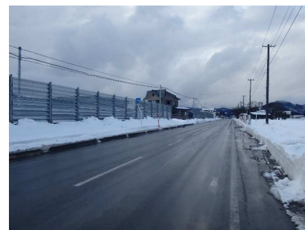
（整備後：防雪柵設置完了）
