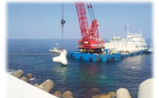
消波ブロック据付状況
