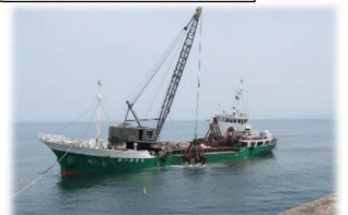
ガット船の基礎捨石投入状況
