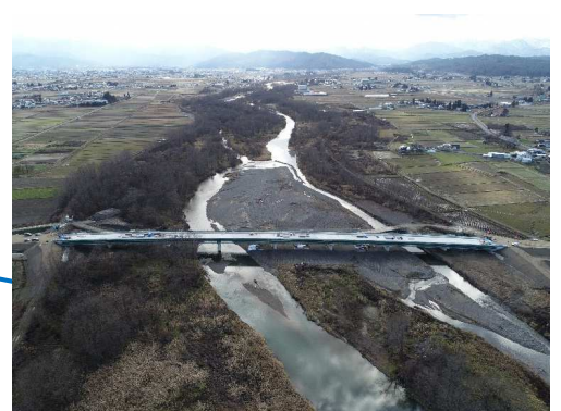
豊穰橋施工状況(米沢市)
