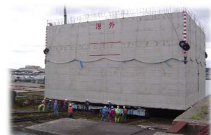
ケーソン進水状況
