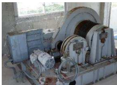
機械設備の補修
