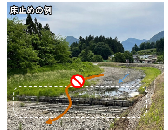
▲②流路保全対策（床止め）の対策後イメージ
