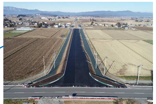
道路土工施工状況(川西町)
