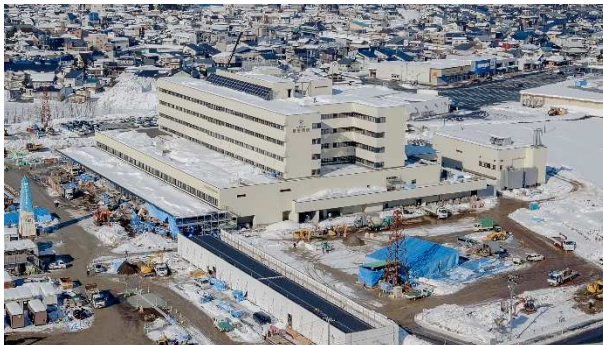
新病院 建設状況 (R5. 1. 19 撮影)
