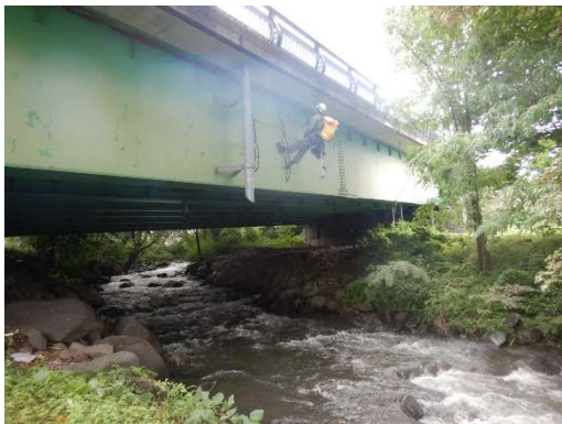
ロープアクセスによる近接目視
