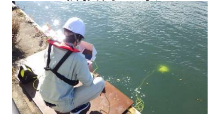
水中ドローンの活用による効率的な点検
