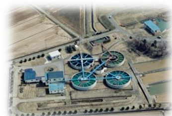
工業用水道浄水場
