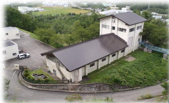
八幡原工業用水道
