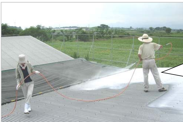
屋根への石灰の吹きつけ（宮崎県）
