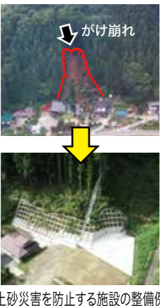
土砂災害を防止する施設の整備例
