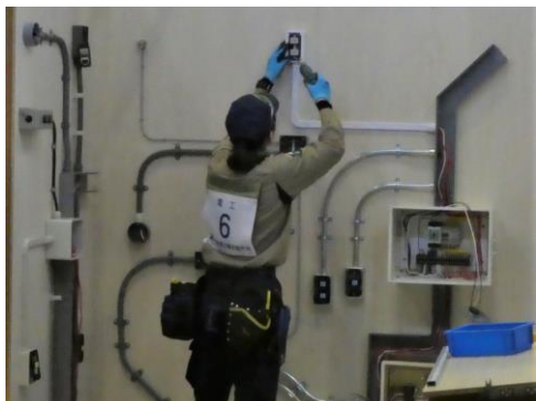
▲技能五輪 電工
