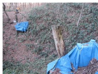
▲神室：「モンキーブリッジ」の橋台
