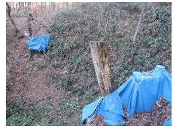
▲神室：「モンキーブリッジ」の橋台
