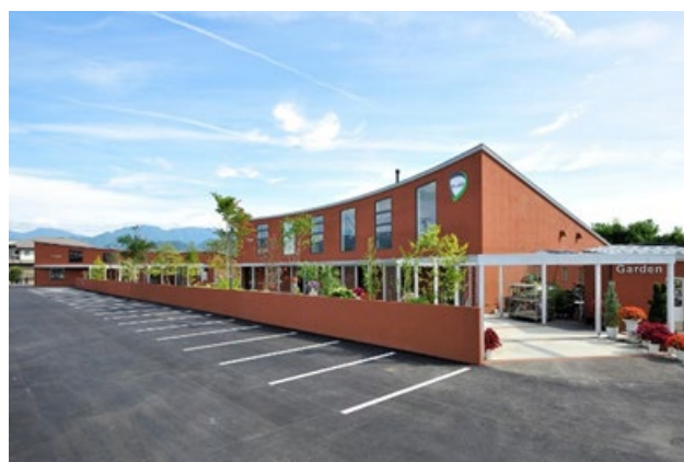
出羽園：瓦壁(廃瓦+樹脂)吹付仕上げ
