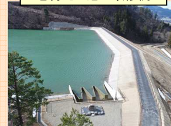
老朽ため池の改修例
