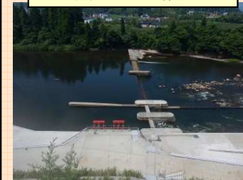
頭首工の整備例
