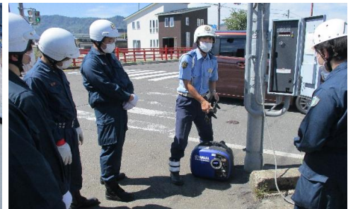
発動発電機で信号機を復旧
