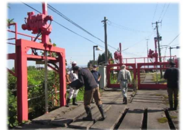
施設点検状況
