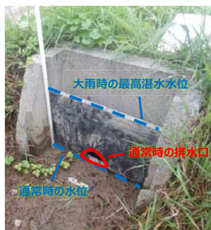
水田に設置されている排水樹と 水位調整板
