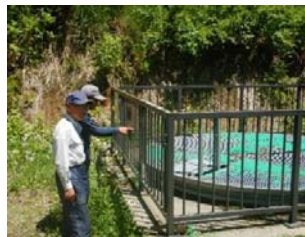
集水井の点検。安全柵等が壊れていないかを確認。
