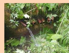
水抜きボーリング
