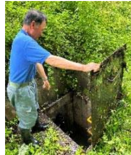
水路等の点検。詰まりや破損などがないかを確認。
