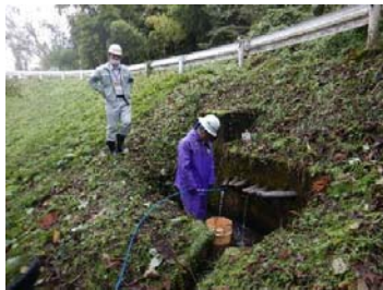
水抜き管洗浄の様子。洗浄することで目詰まりなどを防ぐ。
