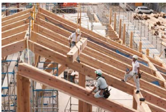
【校舎棟建築現場(鶴岡市立朝日中学校)】
