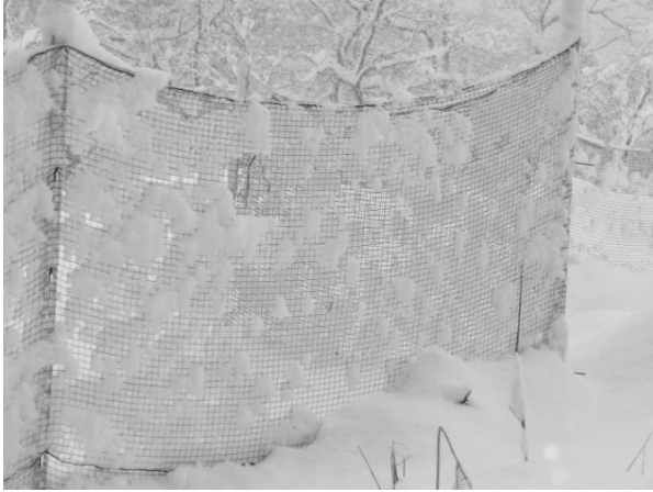
写真-1 ネットの着雪状況
