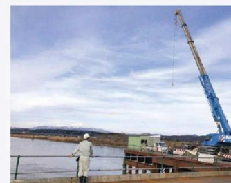
橋梁工事の状況確認
