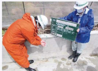
水路工事の完成検査
