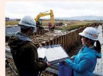
業者との現場確認
