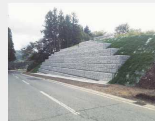
道路改良工事(箱型擁壁)
