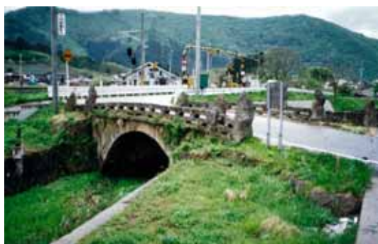
南陽市小岩沢： 吉田橋（明治13年竣工）
