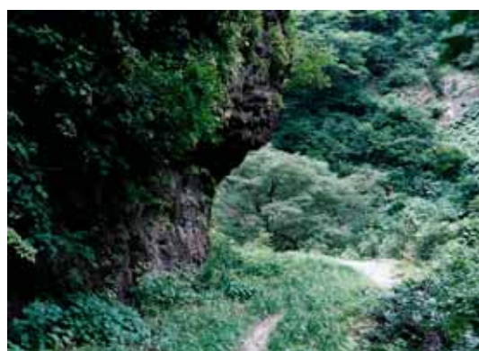
小国町箱の口（桜川溪谷）： 片洞門（明治16年竣工）
