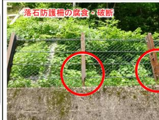
落石防護柵の腐食・破断
